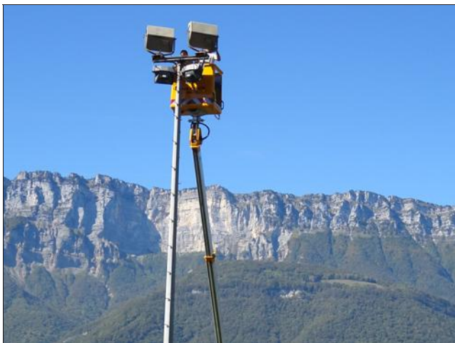
Travaux de haut vol.
