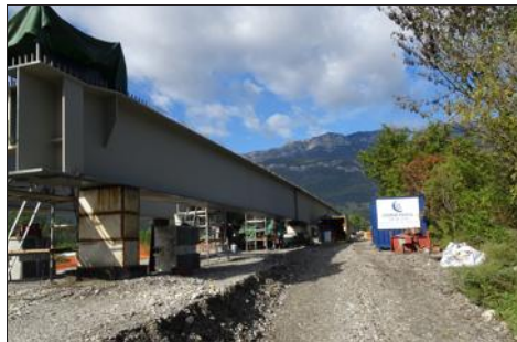
Sous la structure les ouvriers et contrôleurs.
