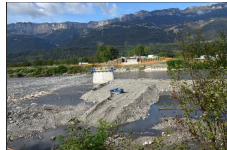
La pile centrale et la rivière en crue.
