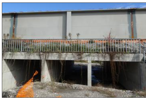
Le pilier central qui reposera sur la pile.
