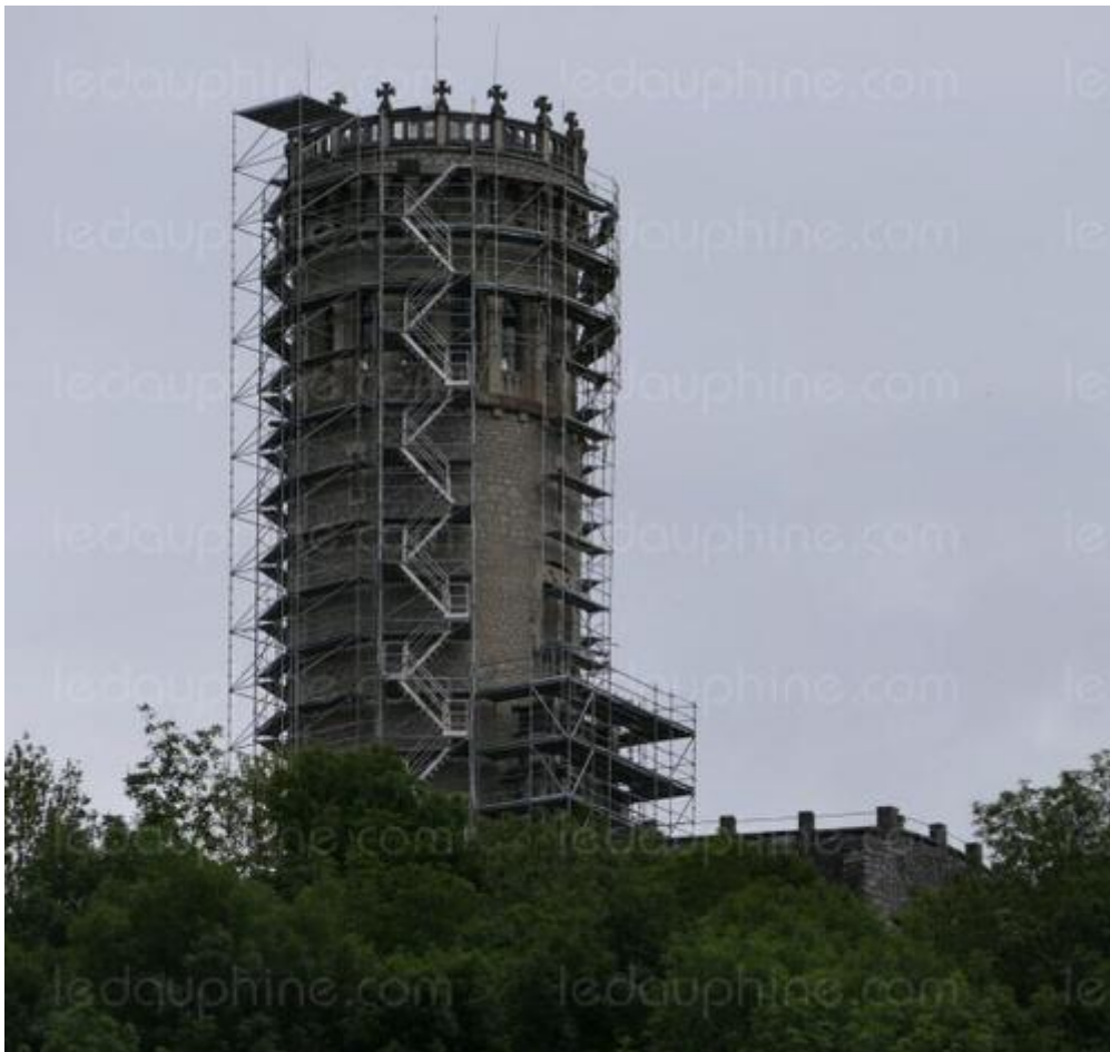
Les supports serviront à l'entreprise de maçonnerie. Photo Le DL /Ag BERNES
