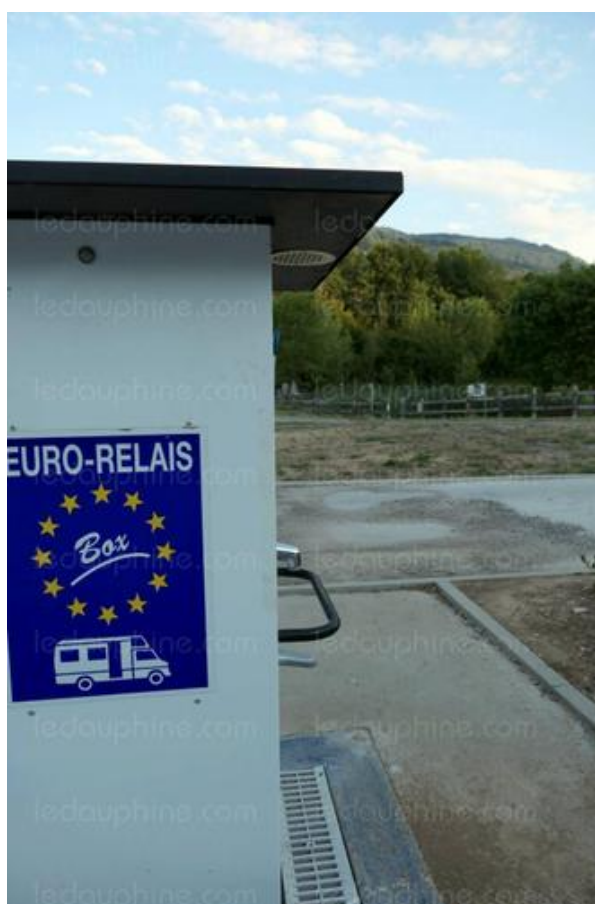
3/3 : L'eau est coupée à l'aire de camping-car. Photo Le DL
