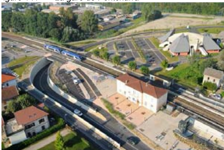
Figure 141 La gare de Pontcharra
