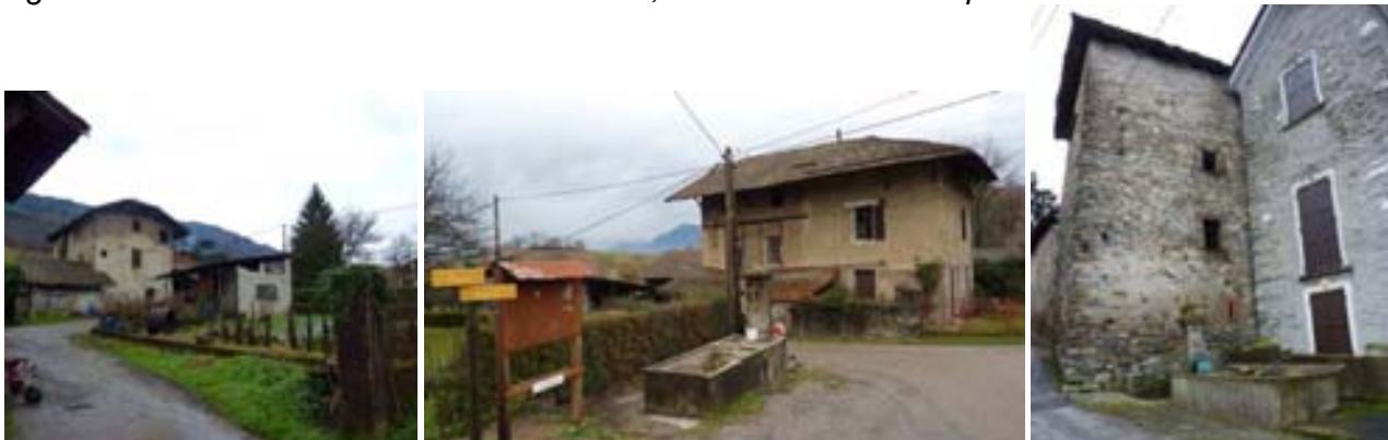
Figure 52 Fermes anciennes à la Combe, lavoir pied du château de Bioni
