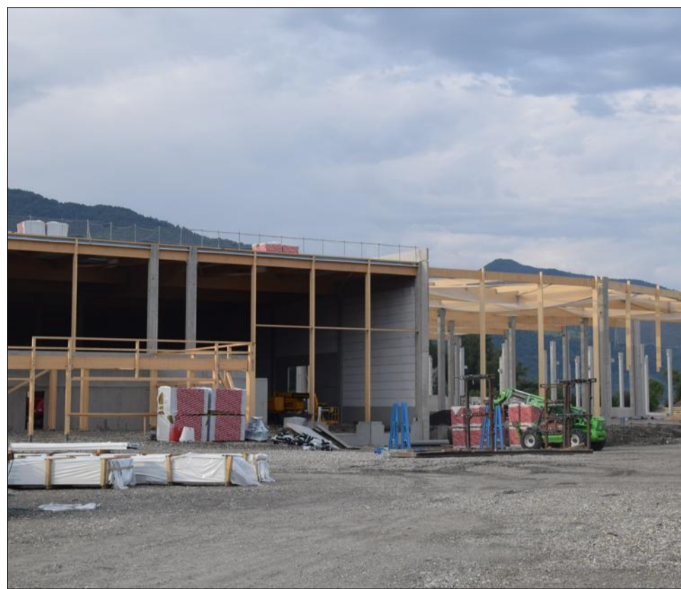
GLD, exploitée depuis 2015, poursuit son développement et construit actuellement un nouveau bâtiment de 24 000 m 2 , attenant au site initial, sur la zone d'activités de Grande-Isle.
