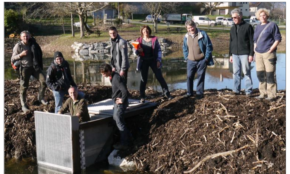
Élus et membres du conservatoire des espaces naturels et du Département ont inspecté les travaux.
