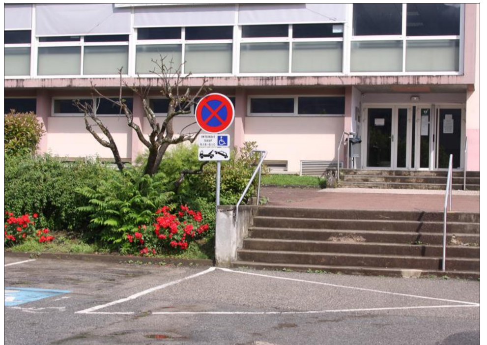
Sur le parvis de la salle des sports, c'est à gauche de l'escalier que démarrera la rampe d'accès.
