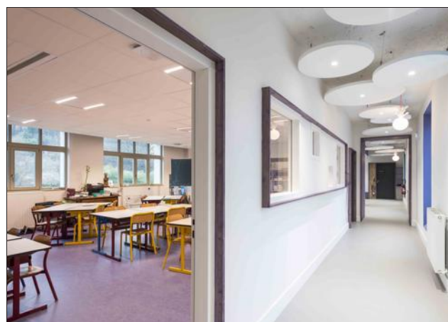
Les finitions ont été soignées avec des sources lumineuses, avec détections de présences, qui se modulent en fonction de la luminosité extérieure. Photo Sandrine RIVIERE
