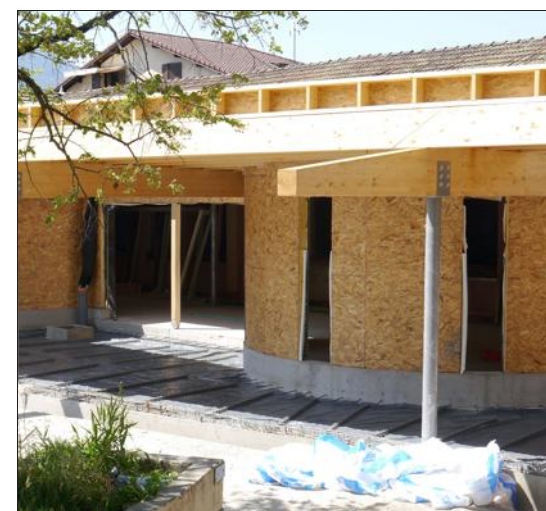
Les travaux en cours à l'école maternelle.
