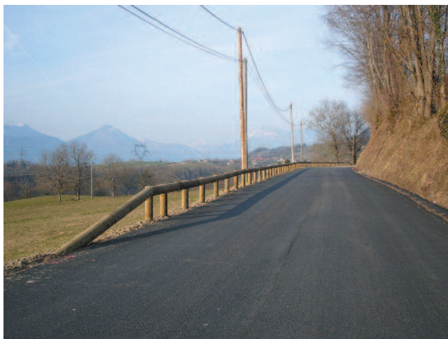
Un exemple de la sécurisation de la RD 9 : la pose de barrières bois à l'occasion du chantier de La Serve
