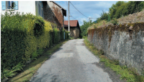
Les reprises sur le chemin entre Avalon et sa Tour
